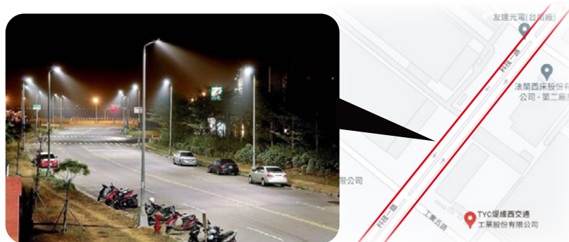
認養路燈 - 科技工業區科技一路
