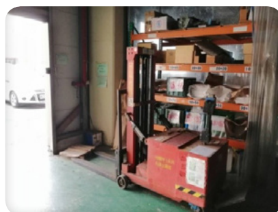
安平廠 C 棟 - 裝設偵煙器
